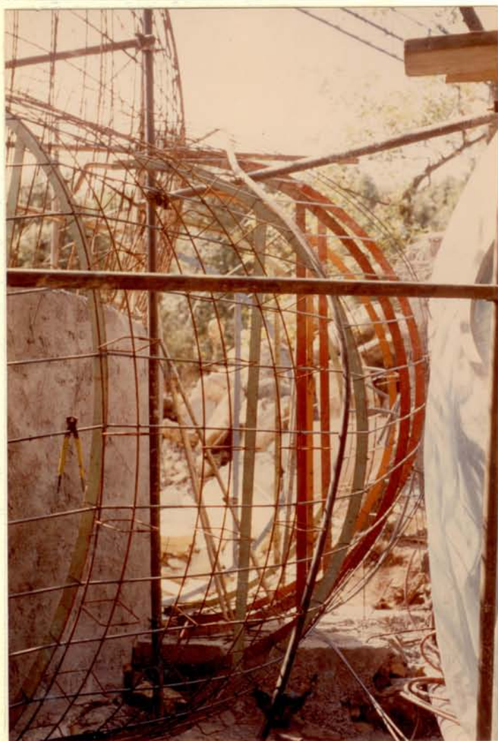
FERRAILLAGE DU COULOIR CIRCULAIRE RECOUVERT DE POUTRAFILS
