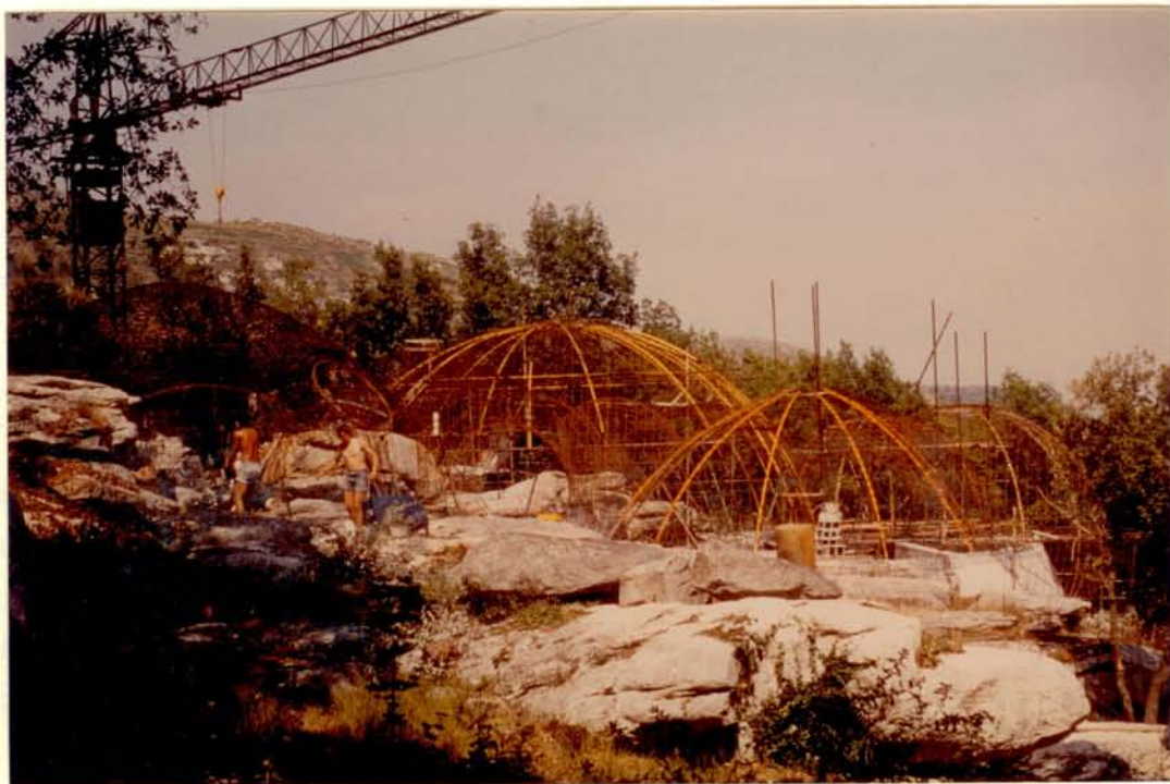
MAISON GAUDET A TOURETTE R -SUR-LOUP Vue générale du chantier
