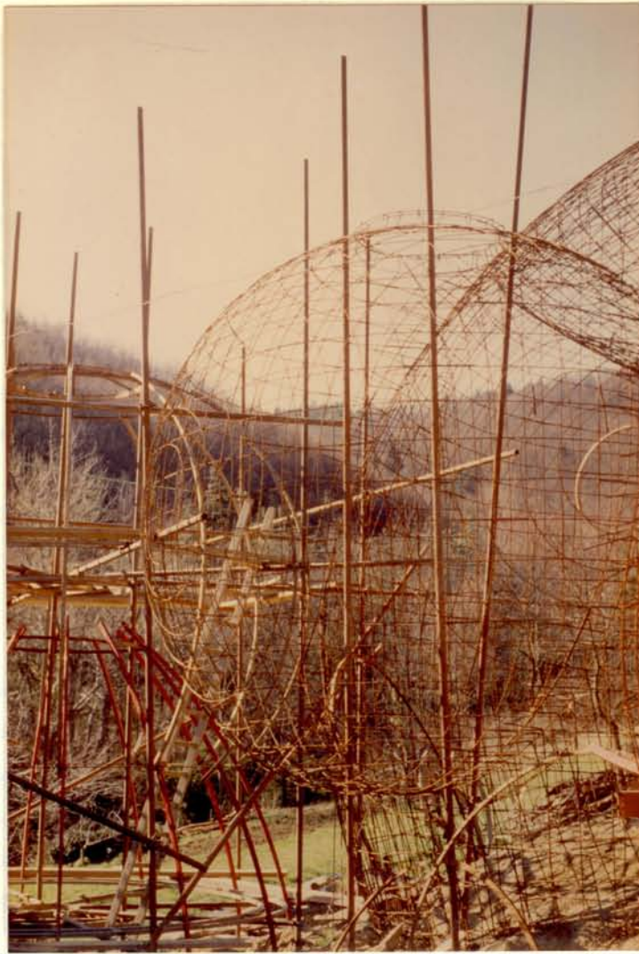
Eclairage zénithal de la cuisine suspendue au ferrailage du séjour
