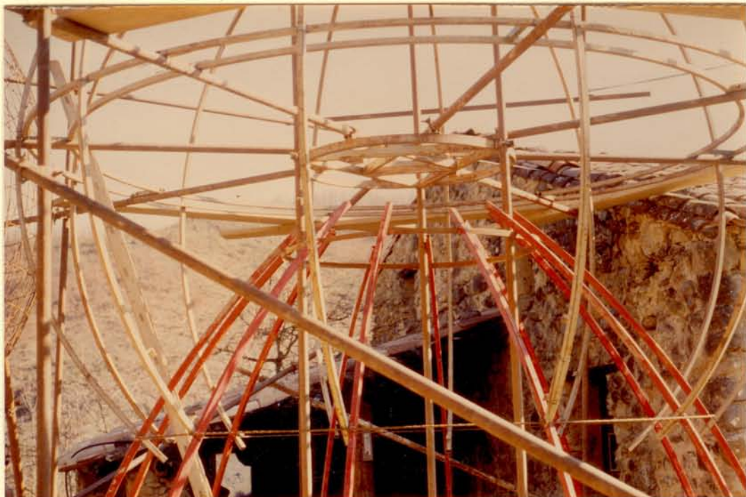
" GABARITS & ECHAFAUDAGE " " Marquage de l'intersection des deux volumes par un fer tor de 8mm "
