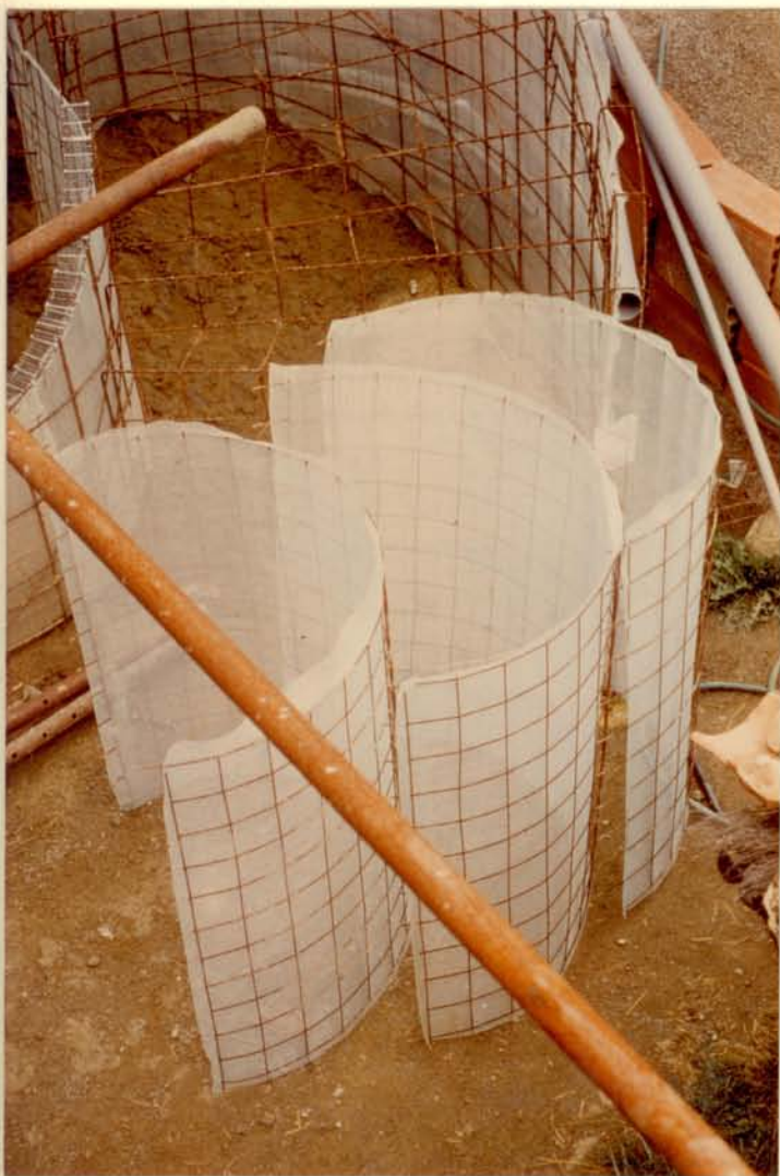
"Matériaux de coffrage"
